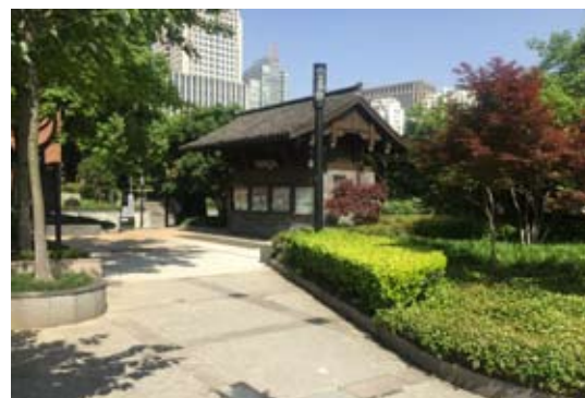
武林门码头售票厅前铺装及绿化完工样貌
