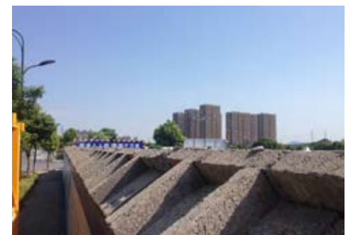
工地洒水防扬尘
