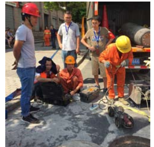
检查市政道路、雨污水管道
